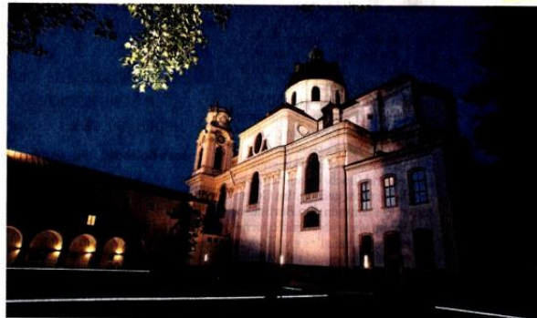
Tatendrang: Die Kollegienkirche wird umfassend restauriert. Bild: SN/ROBERT RATZER
